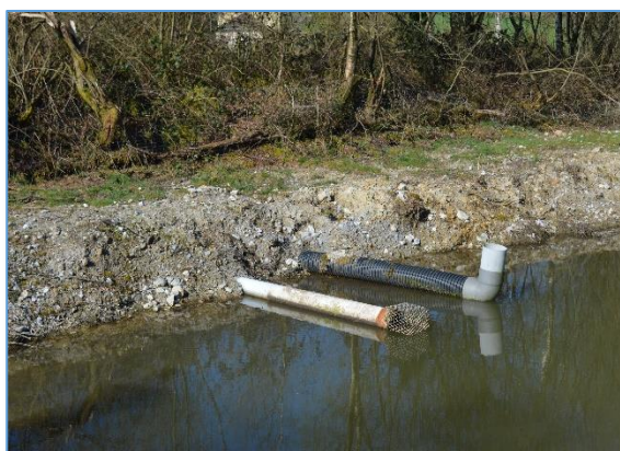
Fig. 6 : Bassin de décantation final et émissaire de rejet
