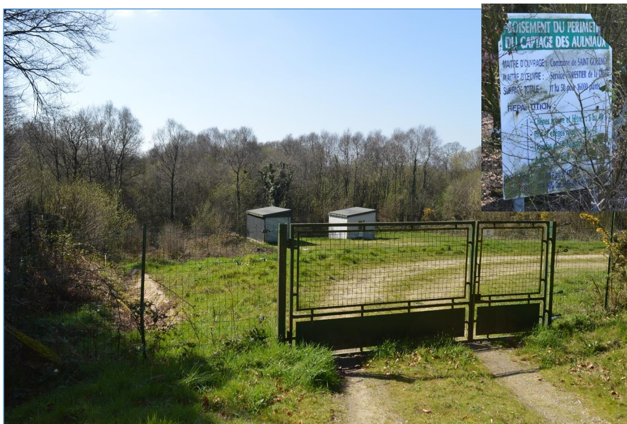
Fig. 16 : Vue sur le captage des Aulniaux
