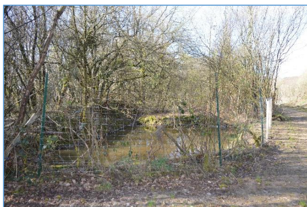
Fig. 5 : Bassin de décantation B1
